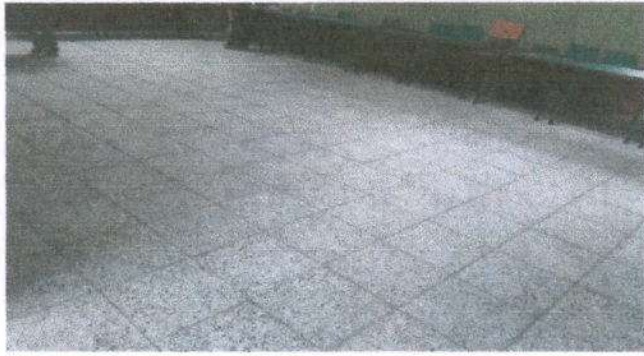
Foto1: Sustitución de piso de torta por granito.
