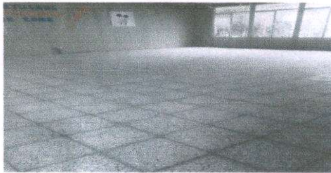
foto 3: Sustitución de piso de tablaroca por granito.
