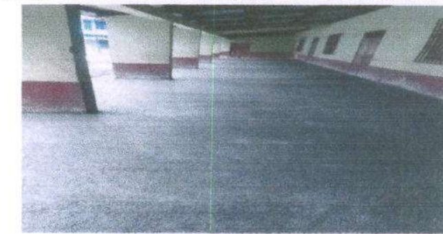
Foto 6: Reparación de piso de torta de concreto.
