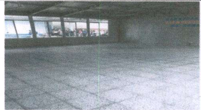
Foto 4. Sustitución de piso de tablaroca por granito.
