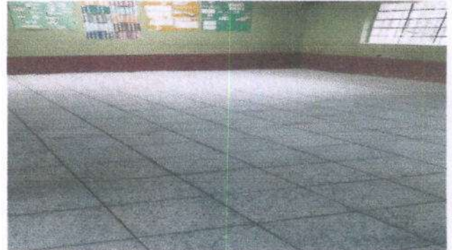
Foto 2: Sustitución de piso de torta por granito.
