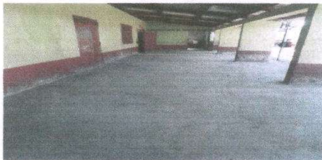
Foto 6. Reparación de piso de torta de concreto.
